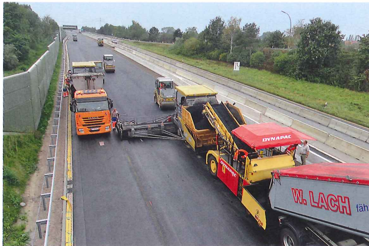
Bild 1: Einbau von Offenporigem Asphalt
