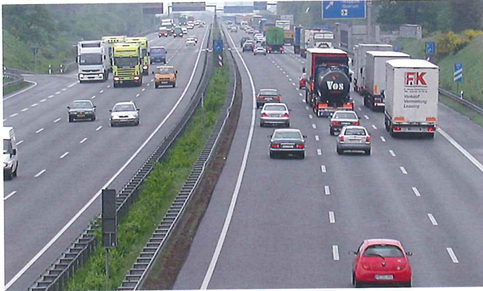
Bild 3: Asphaltdeckschicht aus Offenporigem Asphalt auf der A 2 nördlich von Braunschweig
