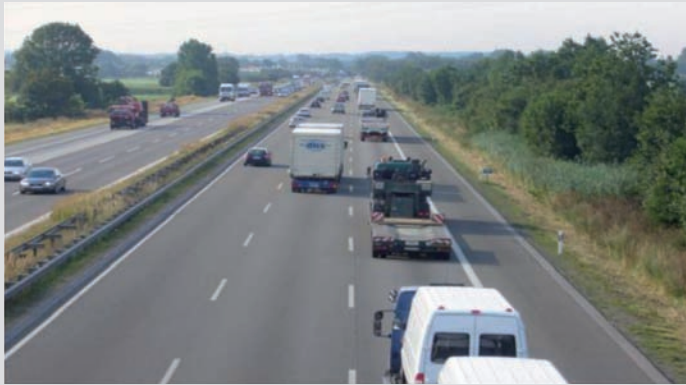
Bild 2: Überblick über das Baulos im August 2006
