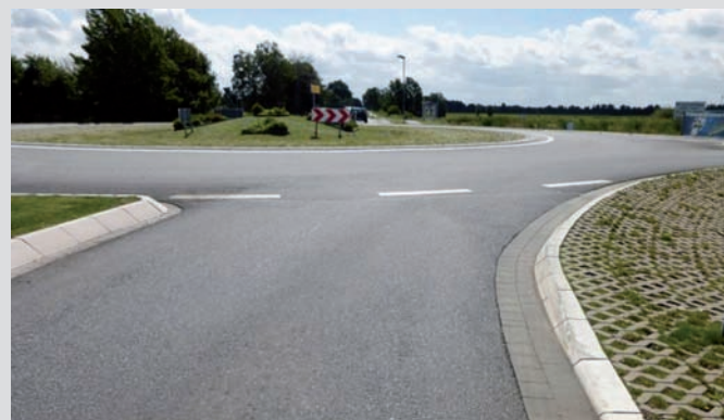
Bild 8: Kreisverkehr nördlich von Aurich mit dichter und ebener Beschaffenheit der Oberfläche der im Dezember eingebauten Asphaltdeckschicht aus Asphaltbeton AC 11 D S mit 25/55-55 A RC und 1,5 % VvoZ nach gut 2,5 Jahren Nutzung
