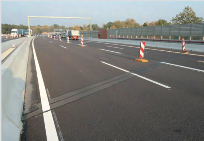
Bild 5: Ausführung einer OPA auf einem Brückenbauwerk mit einem Gussasphalstreifen am Fahrbahnübergang und an der Randeinfassung
