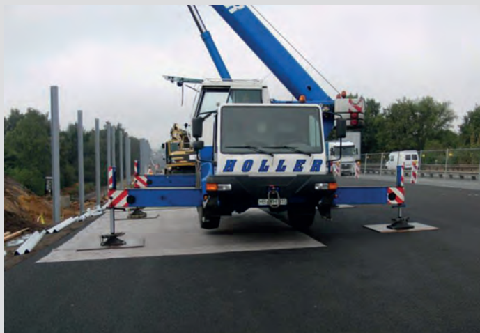
Bild 7: Schutz der OPA vor Beschädigung durch Unterlegen von Lastverteilungsplatten
