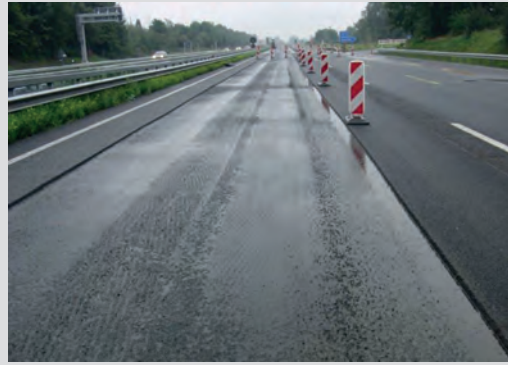
Bild 2: Gefräste OPA auf einer Abdichtung aus Gussasphalt MA 5 S
