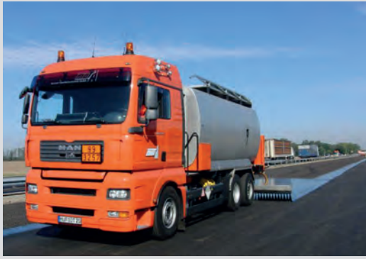
Bild 1: Aufbringen von Polymermodifiziertem Bitumen 40/100-65 A für die Abdichtung der Asphaltbinderschicht mit einer bitumenhaltigen Zwischenschicht mit einem Rampenspritzgerät
