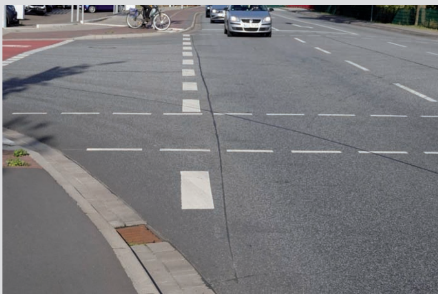
Bild 3: Kreuzungsbereich mit Fugen in der Asphaltdeckschicht bei sämtlichen Nähten und Anschlüssen
